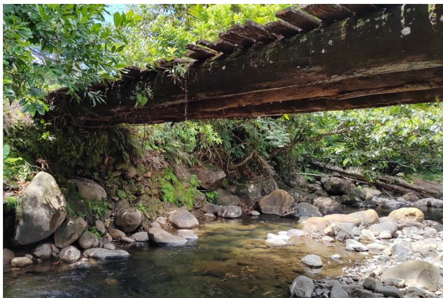
Fotografía 4.: Estado actual del puente. Evidencia de inestabilidad en el margen izquierdo y deterioro de las vigas
