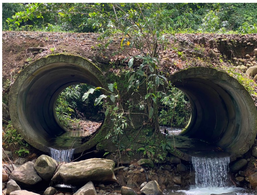
Fotografía 1.: Estado actual de los tubos de concreto con daños provocados
