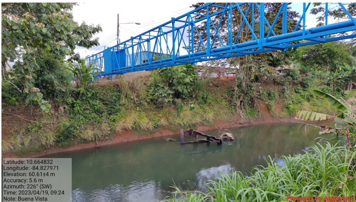
Imagen 7. Fotografía tomada el 19 de abril del 2023 donde se aprecia el lugar donde se encontraba el puente.
