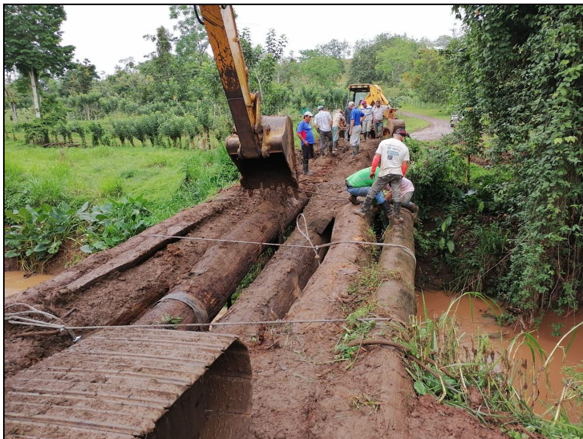
Imagen 7.: Fotografía del proceso de reconstrucción del puente posterior al evento.
