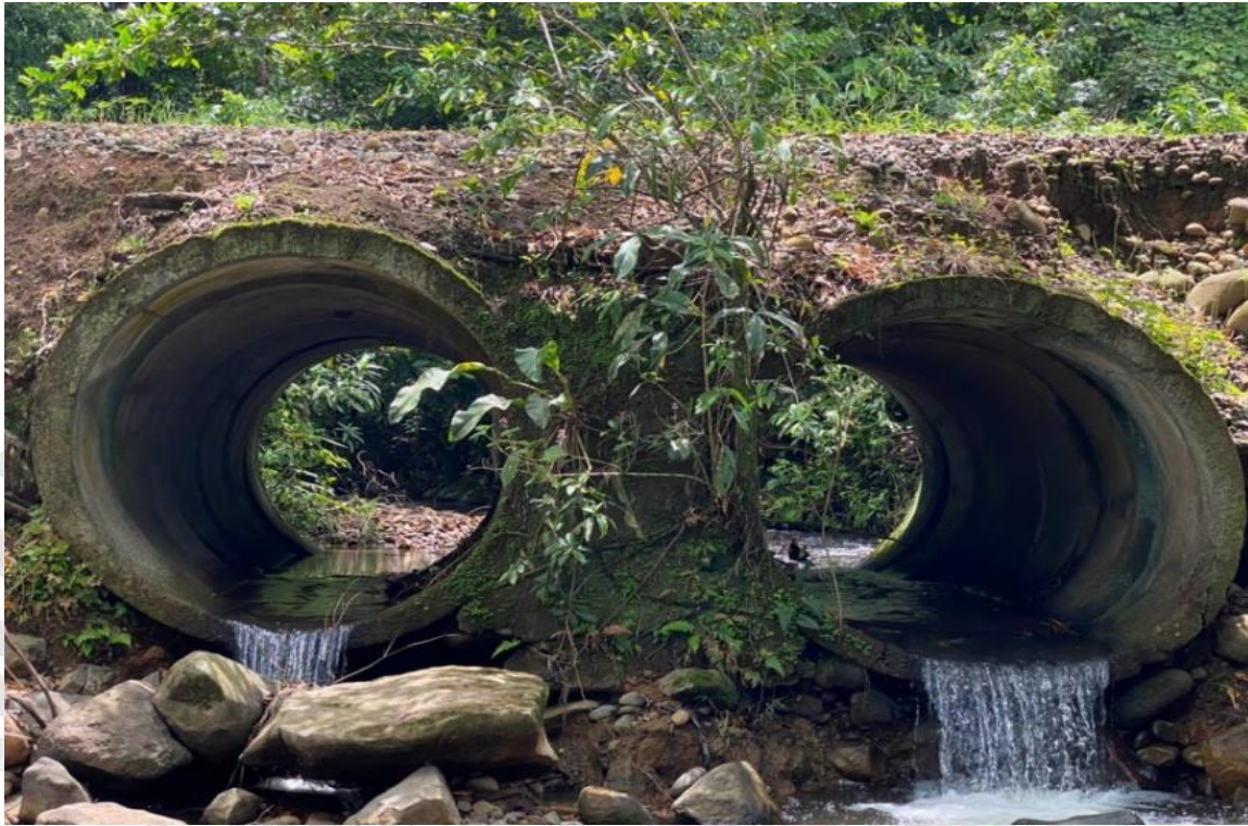
Evidencias de socavación en la estructura debido al exceso de caudal.
