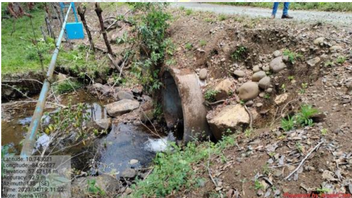
Evidencias de socavación en la estructura debido al exceso de caudal.
